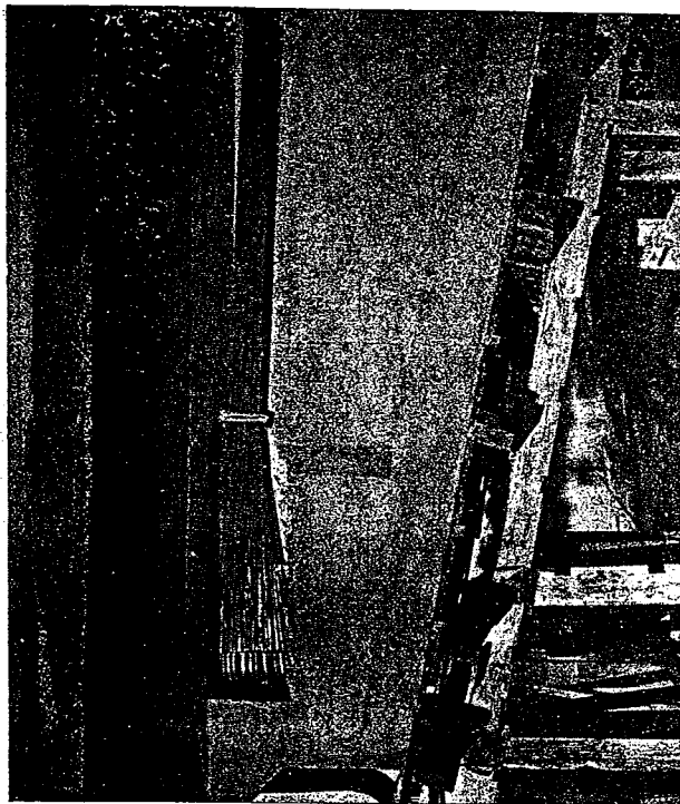
Figs. 4 y 5. Apréciase en la primera la suspensión del tramo isostático (izquierda), y los ventanillos dejados para disponer e' retorno de los alambres de la armadura. En la segunda aparecen estos mismos alambres ya colocados
